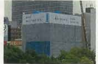
建設現場外観 （仙台駅東口から）
