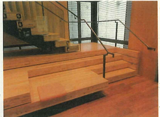
階段・備え付けベンチ
