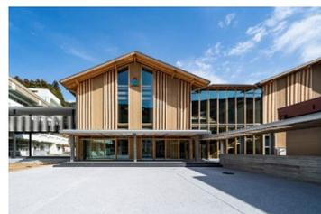
既存の森林整備と木材供給の地域連携体制を活かし、構造材から造作材、家具、CLTまで、地元木材を活用した木造軸組の校舎
