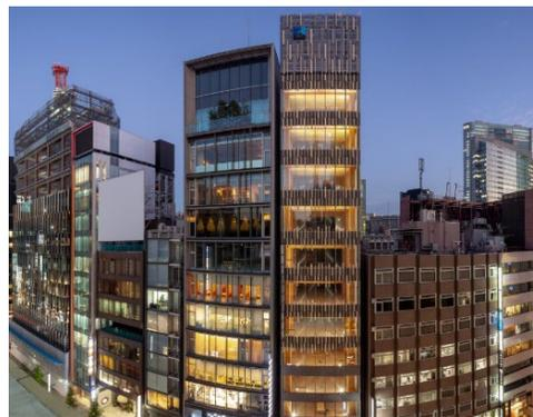
銀座通りに位置する木造ハイブリッド商業施設。日本初となる12層の木造架構を実現し約60mの高さを実現。福島県産材を構造材の多くに使用し、地方の森林と都市の繋がりを体現した都市景観を創出。多くの人々に都市木造の意義を発信し、高層建築が木造になるターニングポイントとなる施設。
