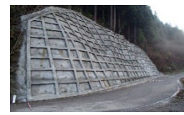
のり面保全による林道の強靱化
