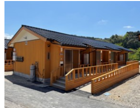
令和6年能登半島地震で整備された木造応急仮設住宅
