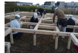
木造応急仮設住宅の 早期供給に向けた訓練
