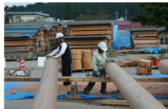
地元大工による丸太材の加工
