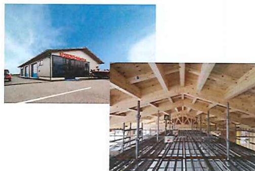
(例)地上1階建て展示場 [実施年度] R元補正 [所在地] 滋賀県 [総木材量] 56㎡ [使用品目] 製材、集成材
