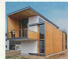
CLT工法による実験棟
