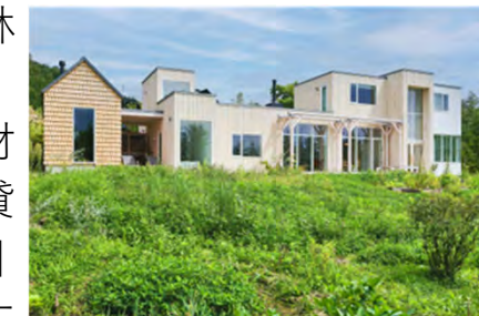
令和6年3月に竣工した木造 宿泊施設「MAISON SHIRO」
