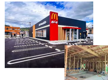
令和6年10月にオープンした 木造店舗 安芸熊野店 (広島県)
