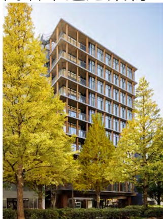
ウッドライズ仙台 (宮城県仙台市、令和5年11月竣工) [10階建て]
