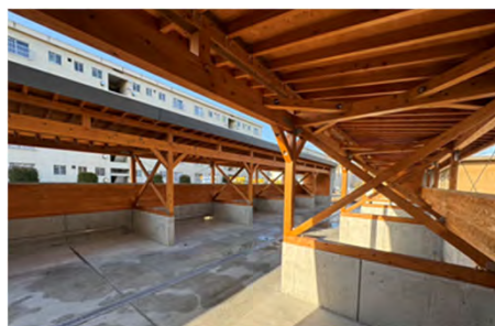
財務省 合同宿舎渡鹿住宅 自転車置場 (熊本県)
