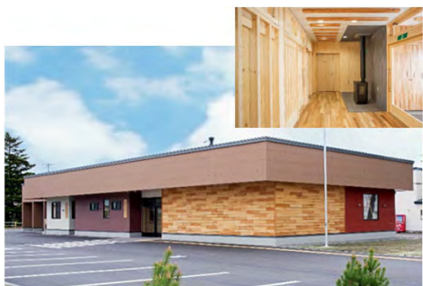
農林水産省 北海道森林管理局 森林技術・支援センター 庁舎(北海道)
