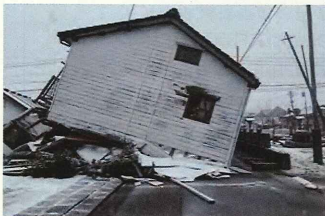
＜木造住宅の被害＞
