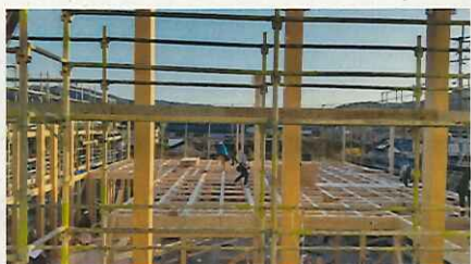
建設中の様子
