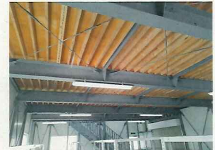
警察庁 青森県警察機動隊倉庫 (青森県) [室内天井]
