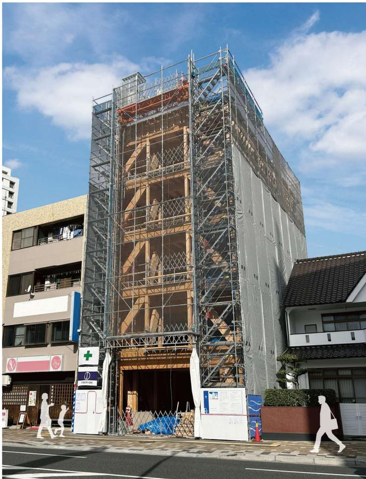
広島市の準防火地域に建設中の、西日本初の純木造軸組5階建てビル。木造の躯体で軽量化を図り、杭基礎工事を不要とした。国産カラマツ・スギを活用し、連続的な開口部から木のプレースを見せて木造らしさをアピールしている。
