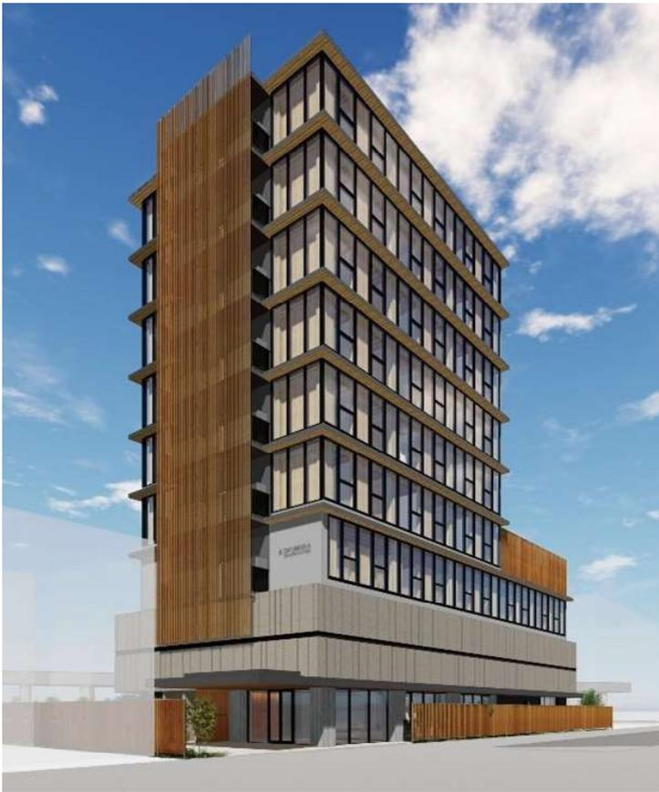
2023 年 11 月に着工した、埼玉県川口市で建設中の奥村組の社員寮。建物の 3～8 階部分が木造で、約 250 m<sup>3</sup>の木材を使用する計画としており、木材利用による炭素貯蔵量（CO<sub>2</sub>固定量）は約 170t と見込んでいる。
