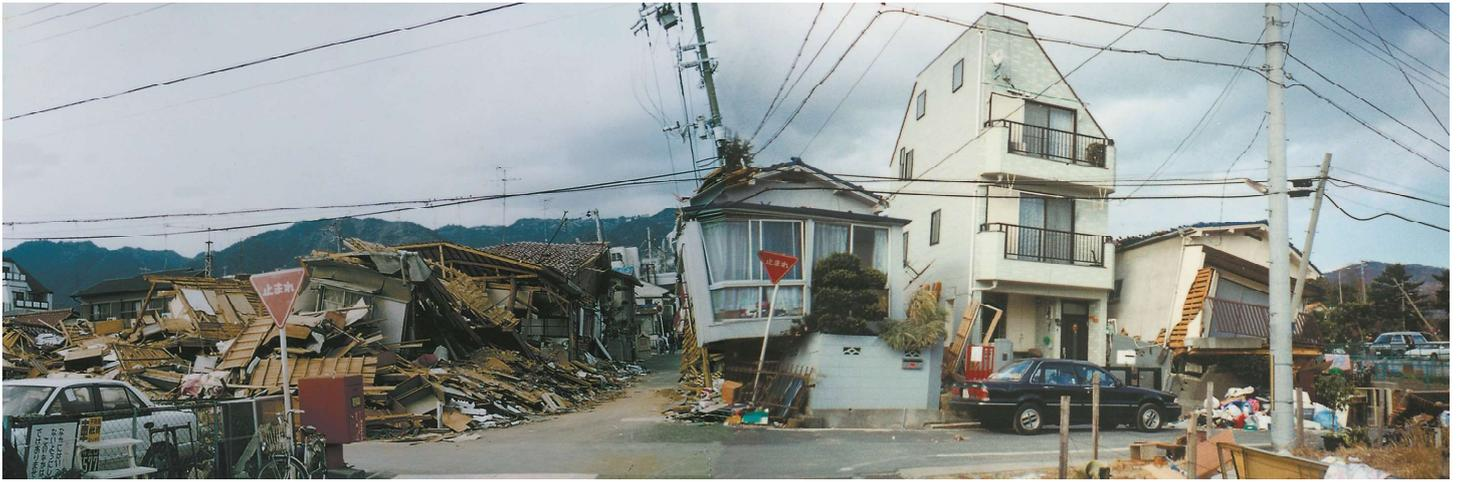
1995 年に発生した阪神・淡路大震災の際、最大震度 7 を観測した神戸市灘区では、鉄筋コンクリート造のマンションが倒壊してしまうほどの甚大な被害を受けていた。しかし、接合金物工法「KES 構法」による木造 3 階建て住宅（N 邸）は倒壊を免れた。調査の結果、被災地に建っていた 73 棟の KES 構法による木造住宅が、倒壊を免れていたことがわかった。接合金物工法は木造建築の主流になり、現在では住宅から大規模・高層木造建築まで幅広く採用されている。
