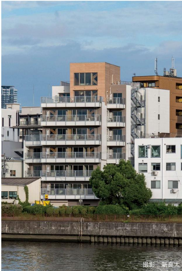
2024年に竣工した、大阪城の北側に位置する、西日本最高8階建て木造ハイブリッドマンション。敷地に下水暗渠があり、そこを避けて杭を配置している。杭基礎への荷重負担を減らすため、木造の混構造として計画した。
