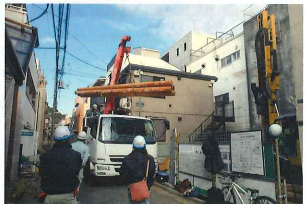
狭小地での丸太搬入状況
