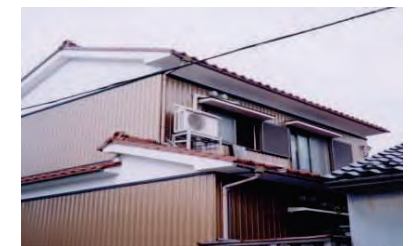
防音工事実施後
