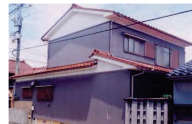
防音工事実施前
