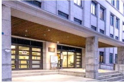
参議院 参議院別館（東京都）〔玄関庇裏〕
