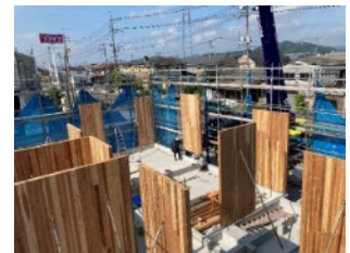
木造事務所建設の様子
