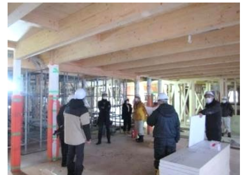
内覧会（施設整備中）の様子
