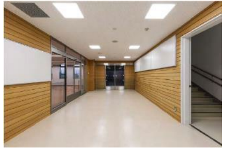
厚生労働省 春日井公共職業安定所(愛知県)〔壁〕
