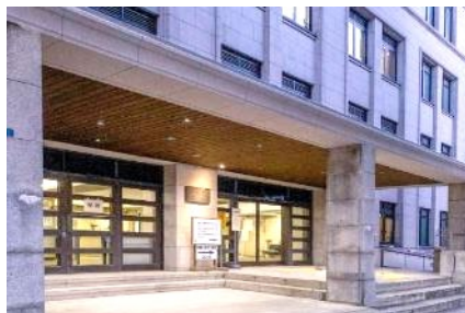
参議院 参議院別館（東京都）〔玄関庇裏〕
