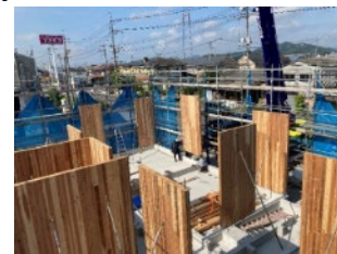
木造事務所建設の様子
