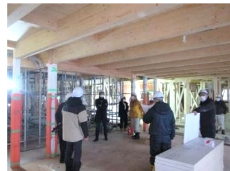
内覧会（施設整備中）の様子
