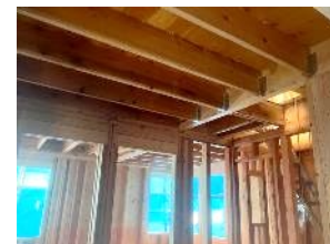
供給を開始した 国産2×4製材の 横架材
